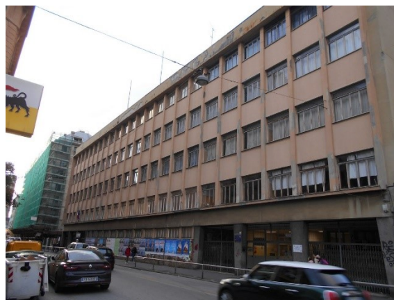
Figura 1.1 - Particolare della facciata principale
