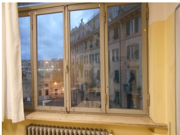
Figura 2.2 - Particolare dei serramenti
